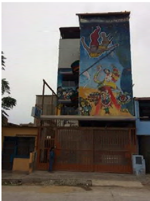
Puerta de ingreso Av. Álamos
